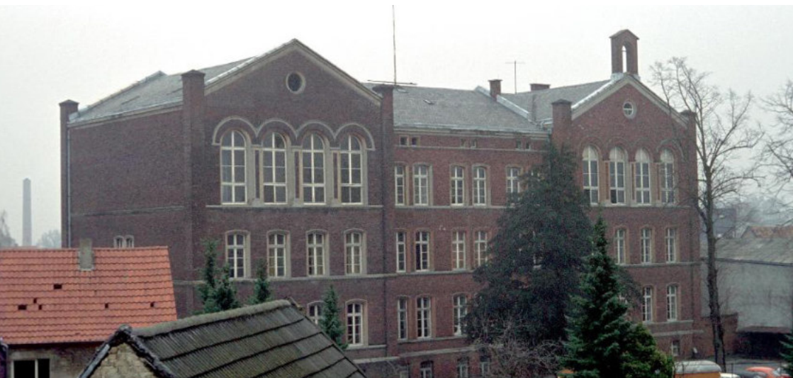
Das Gymnasium an der Wasserstraße. Foto: Pape
